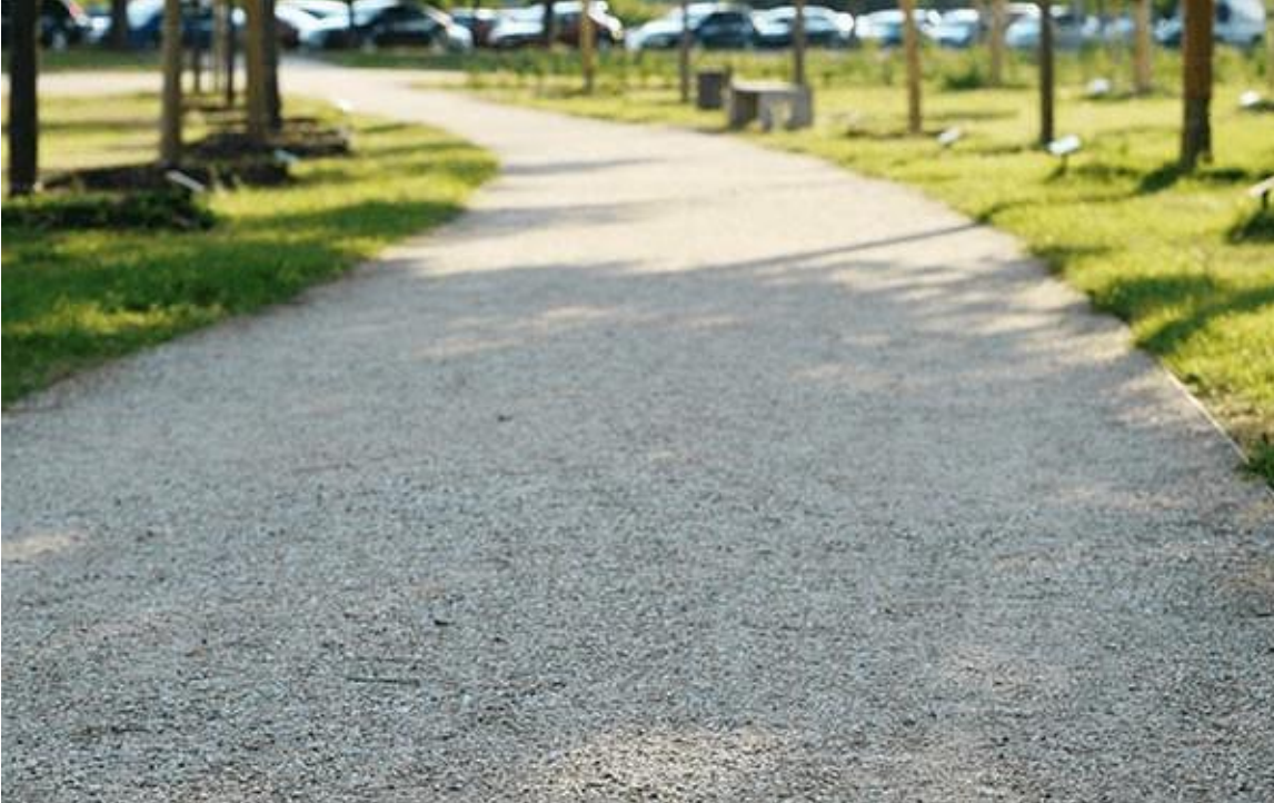
Abb.: Hydraulisch gebundene Decke (Splitt Belag)
